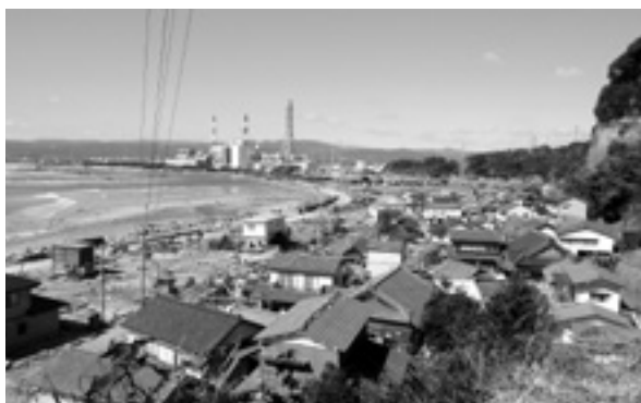
図9 東日本大震災の大津波は防潮堤を破壊。集落は大きな被害 〔2011(平成23)年3月18日 佐川紘一氏撮影〕
