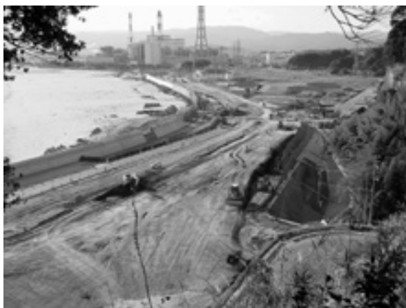
図10 防潮堤のかさ上げ、道路の付け替え、防災緑地の建設が それぞれ進行。新しい集落はその背後に配置 〔2016(平成28)年1月 いわき市撮影〕
