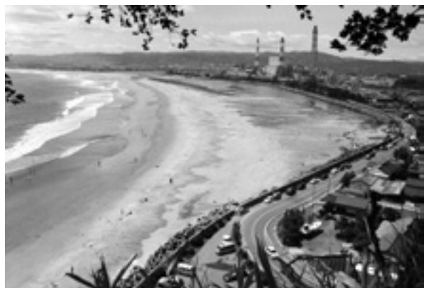
図8 河川改修によって砂州が拡大。高潮対策のため、防潮堤が海岸よりに建設。道路も海岸よりに付け替えられた。〔1996(平成8)年 いわき市撮影〕
